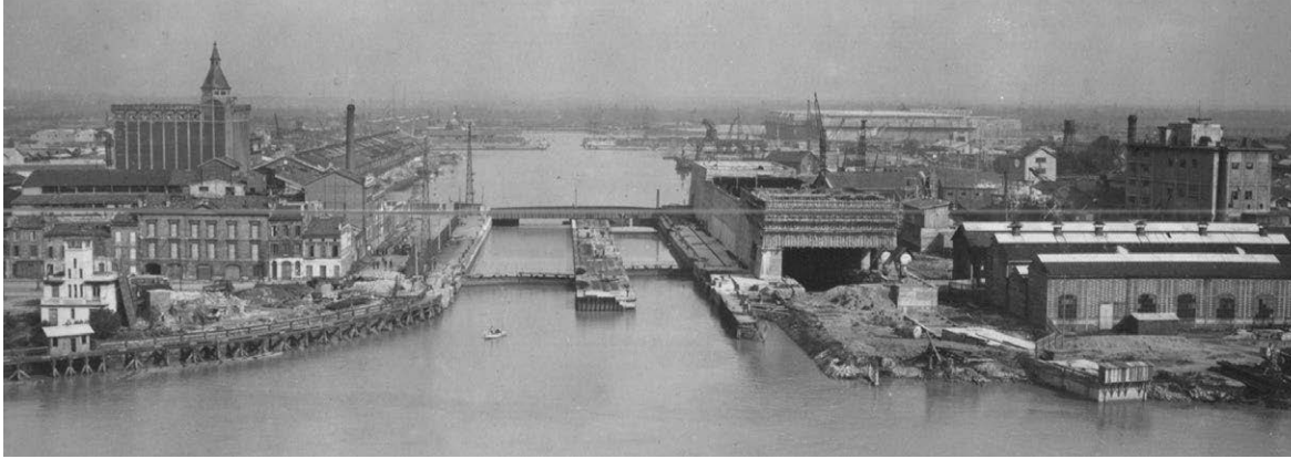
Un bunker recouvre l'entrée des bassins à flot à Bordeaux en 1946. © archives port autonome de Bordeaux.
