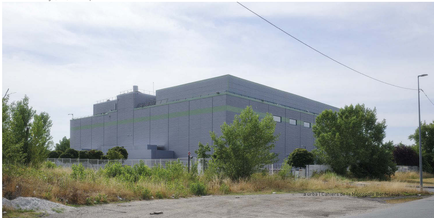
Data center UltraEdge (SFR) dans le quartier de Bordeaux-Lac.
