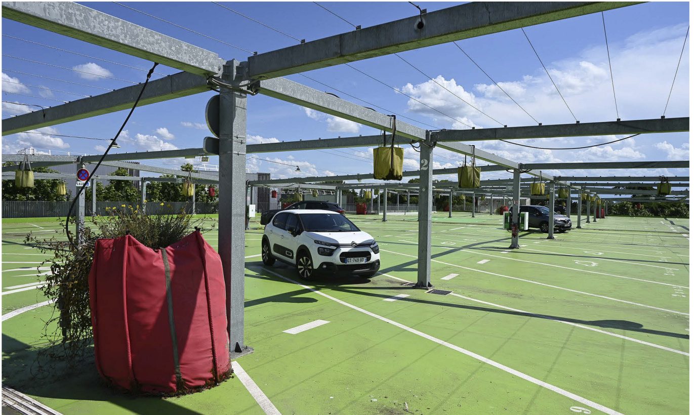
Sècheries, dernier étage du parc de stationnement. crédit photo a'urba
