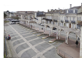
Gare routière de Libourne.
