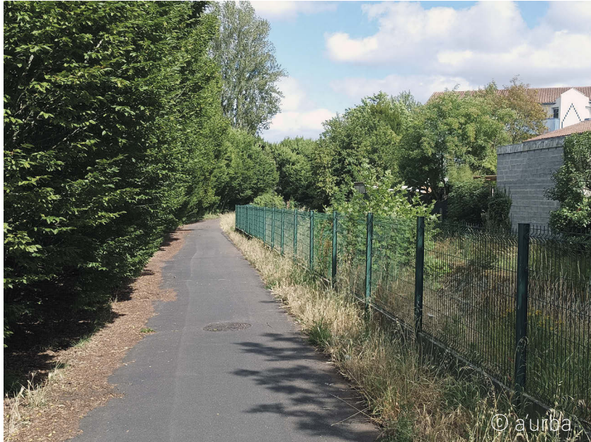
C. Chemin de la Devèze à Mérignac Longueur : 1 km
