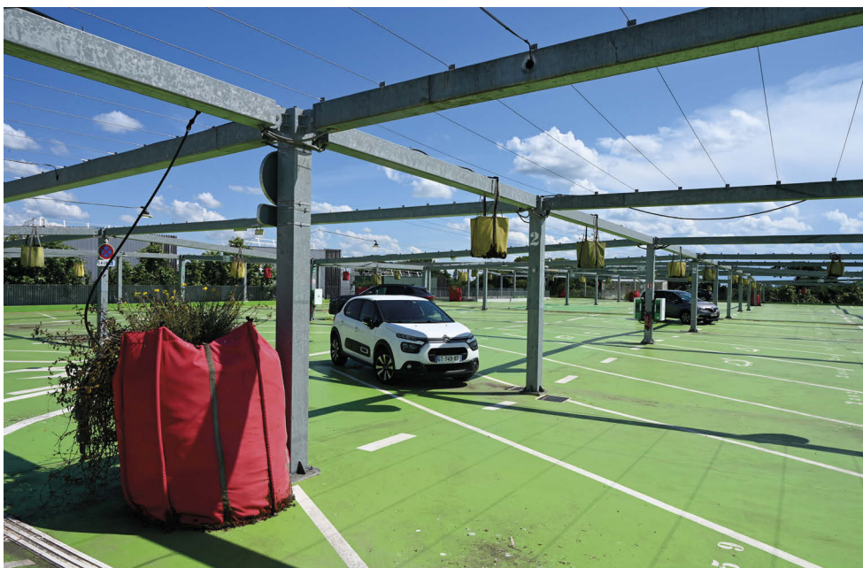
Dernier étage du parking Metpark © a'urba
