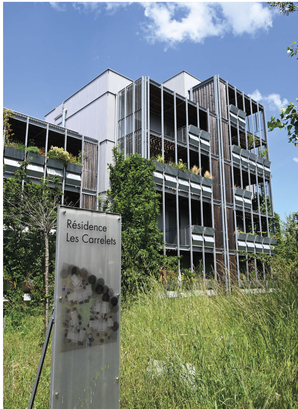
Façade de la résidence Les Carrelets © a'urba
