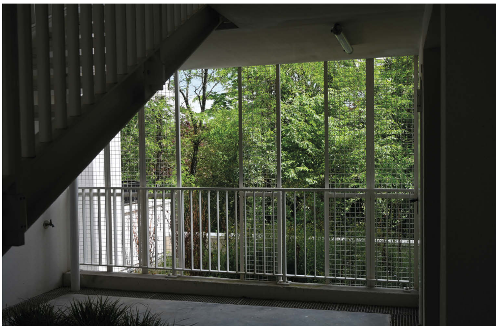
Vue depuis une coursive vers l'extérieur © a'urba
