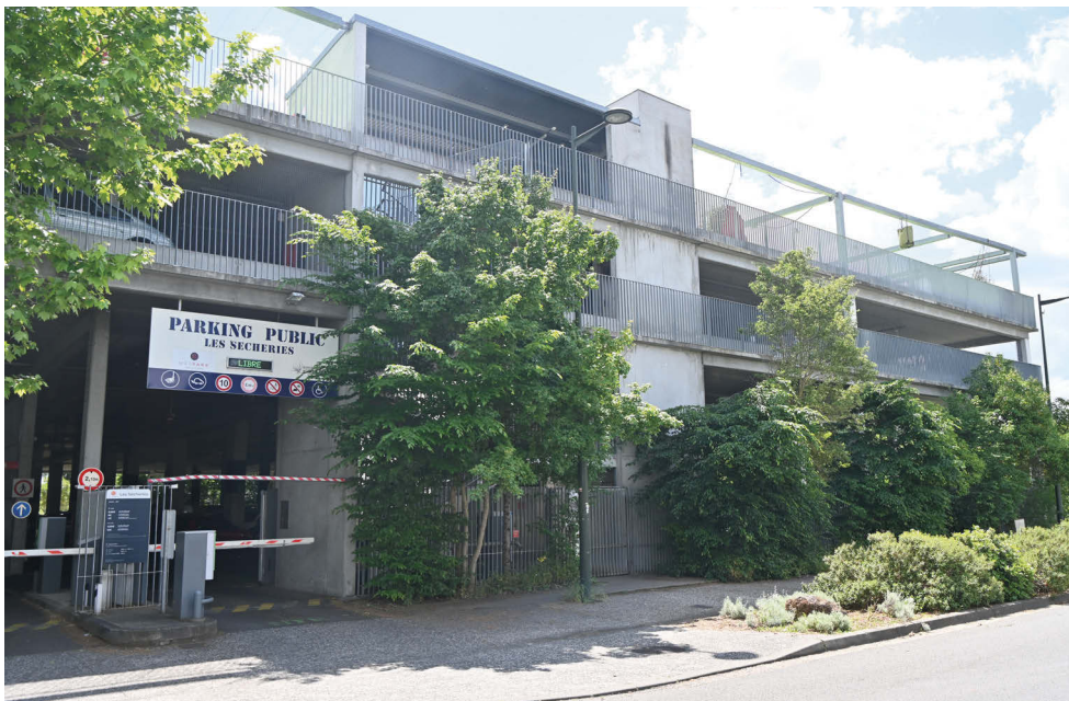
Entrée du parking Metpark © a'urba
