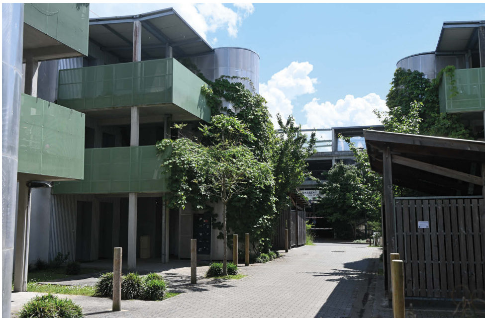
Cheminement piéton pour accéder à la résidence Origami © a'urba
