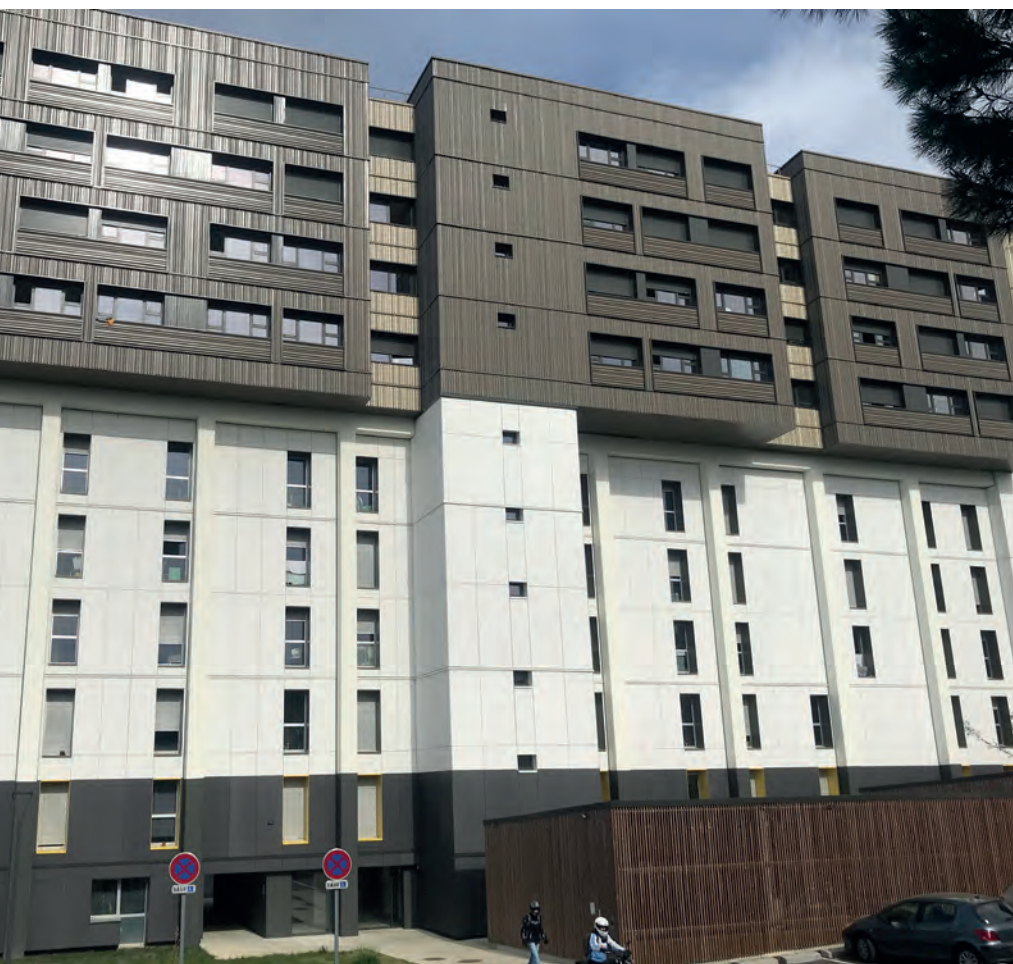
Surélévation du bâtiment G du Crous, Gradignan. Quatre étages soit 112 logements étudiants supplémentaires, reposant sur un exosquelette en bois. © C.Philippe.
