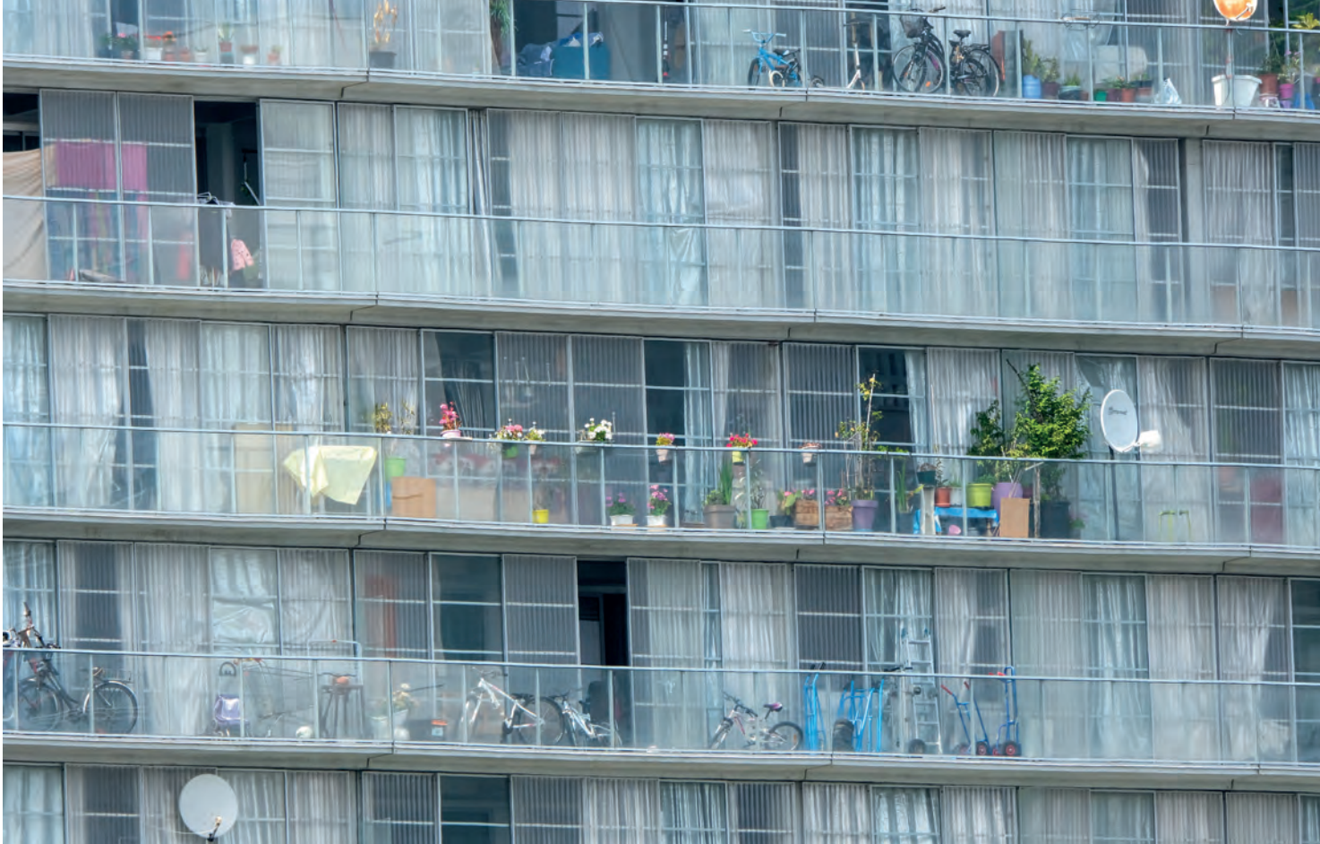
Transformation de 530 logements, bâtiments G, H, I, quartier du Grand Parc à Bordeaux, 2017. Architectes : Lacaton & Vassal, Druot, Hutin.
