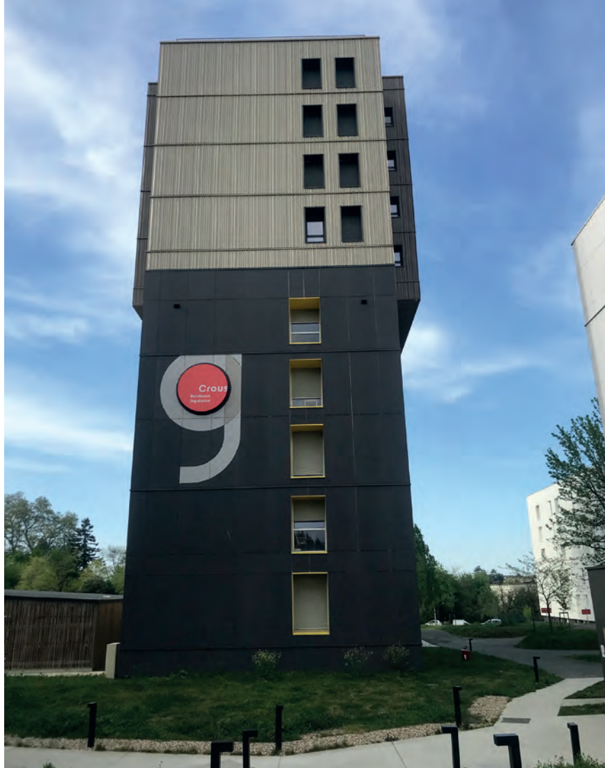
Surélévation du bâtiment G du Crous, Gradignan. Quatre étages soit 112 logements étudiants supplémentaires, reposant sur un exosquelette en bois. © C.Philippe.
