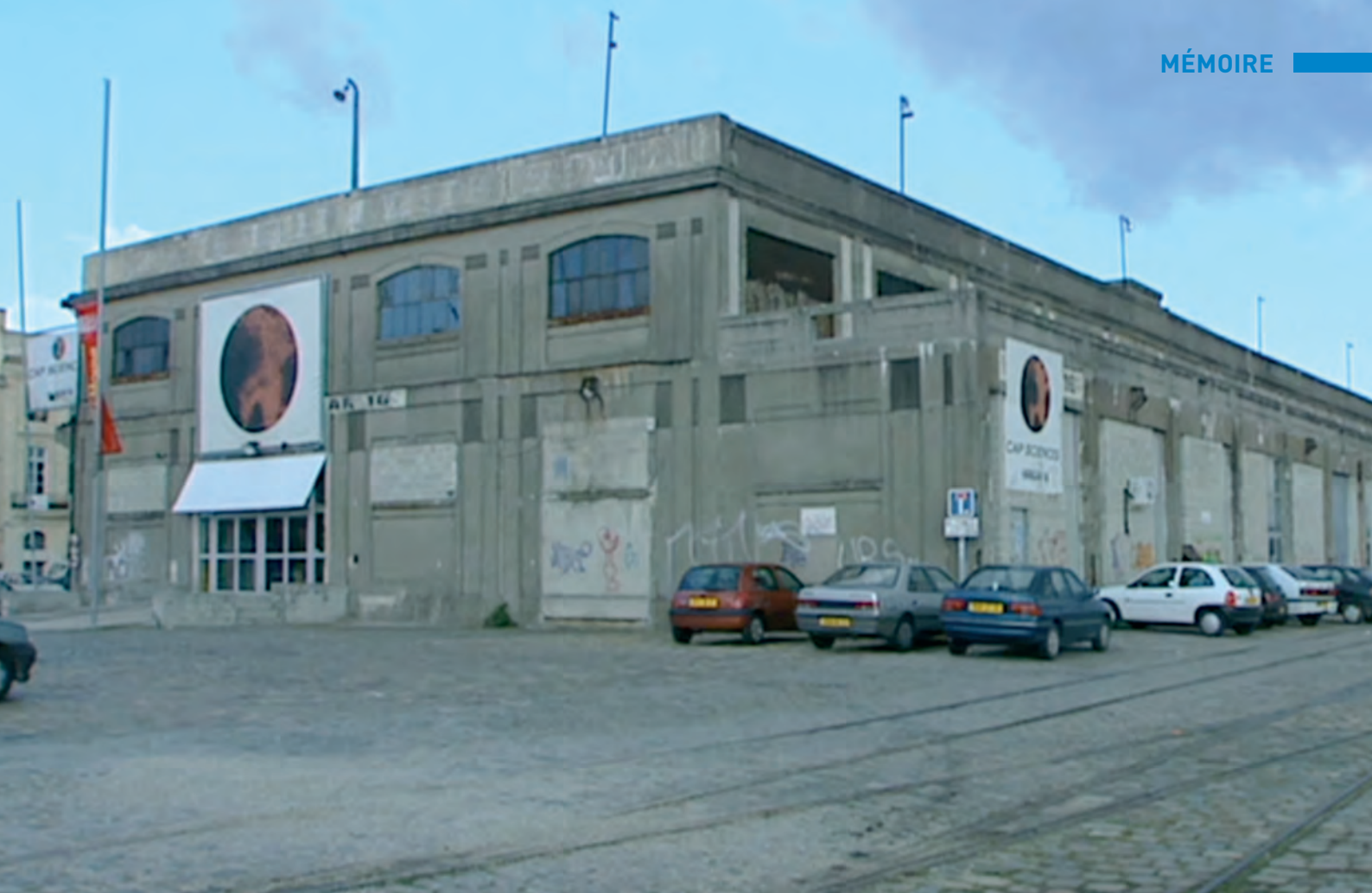
Cap Sciences fut installé provisoirement au hangar 16 jusqu'en 2002. © La mémoire de Bordeaux Métropole.
