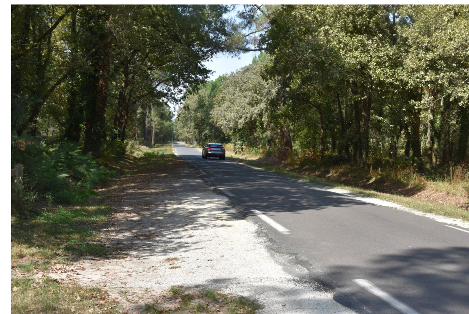
Chemin du Foin avec poche de stationnement latérale
