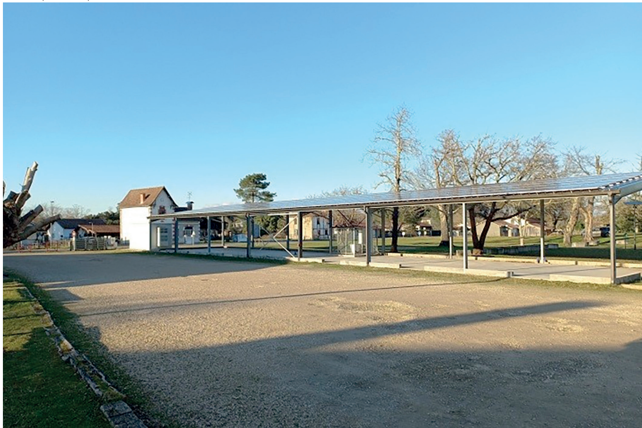
Ombrière photovoltaïque. © Commune d'Escource.
