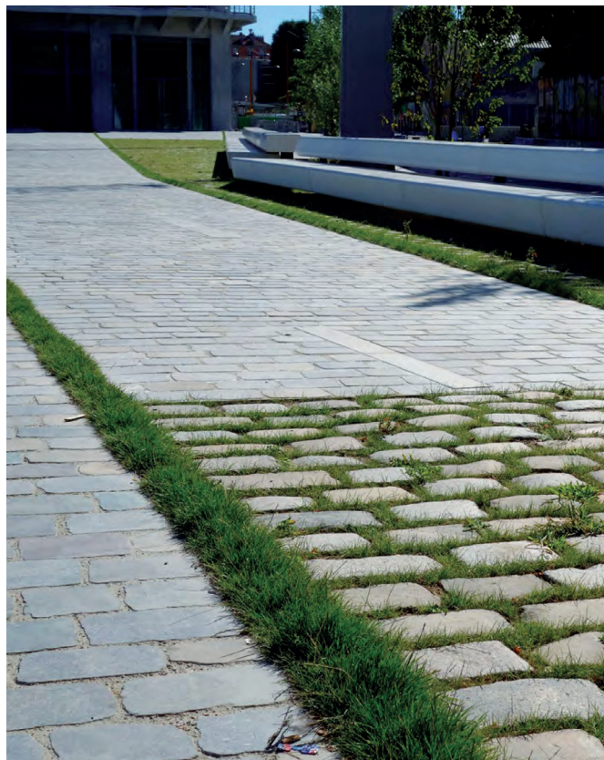
Filets verts et pavés enherbés, Place de la Pointe - Paris, © Est ensemble Grand Paris
