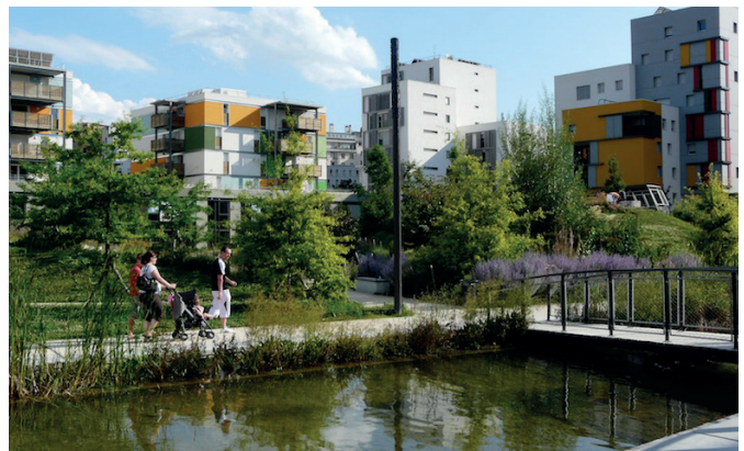
Bassin en eau, ZAC de Bonne, Grenoble, © Vivre en ville
