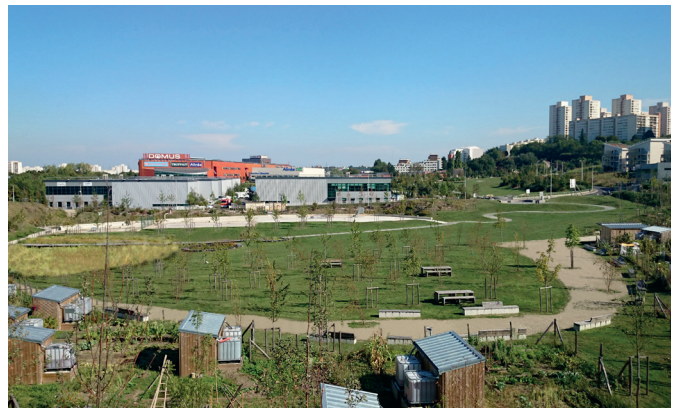
Parc « rivière », ZAC des Guillaumes, Noisy-le-Sec, © Urbanwater
