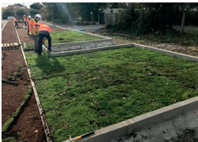
Désimperméabilisation d'un parking sur la commune de Port-Leucate, © Ville de Narbonne
