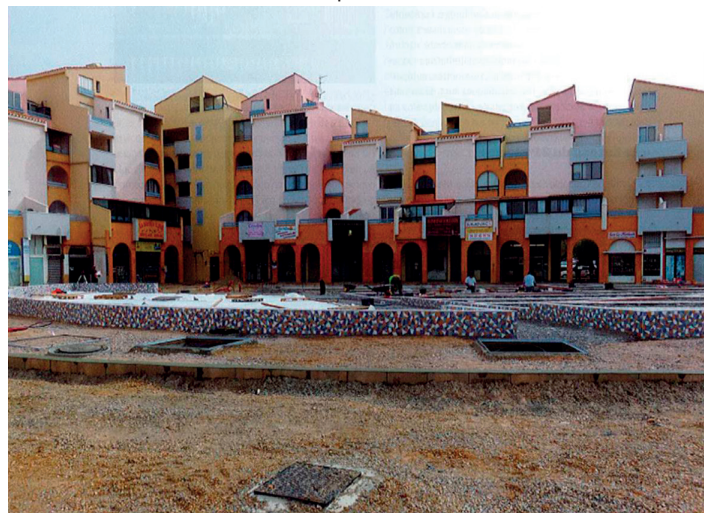
Désimperméabilisation du Port de Leucate, Ville de Leucate, © Agence de l'eau Rhône-Méditerranée-Corse
