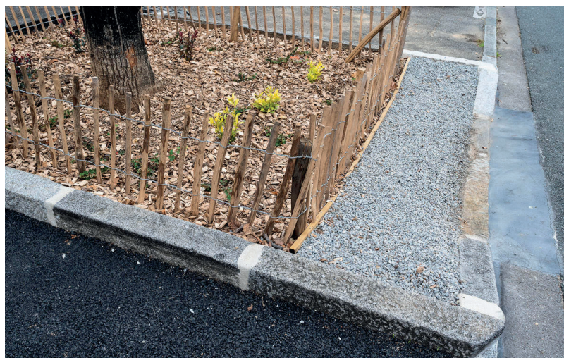
Autour de l'arbre, le bitume laisse la place à un sol qui laisse l'eau s'infiltrer, © Thierry Fournier, Métropole de Lyon
