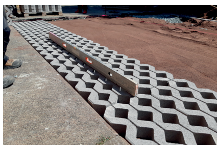
Pose du revêtement final, © Grand Lyon
