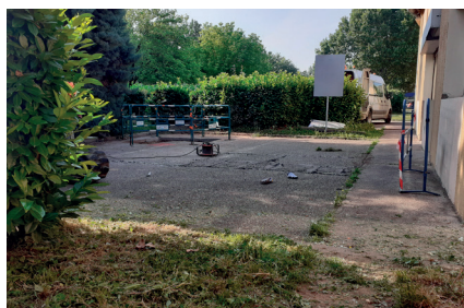
Préparation du chantier, © Grand Lyon
