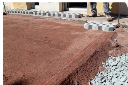
Pose d'une surcouche de sable, © Grand Lyon
