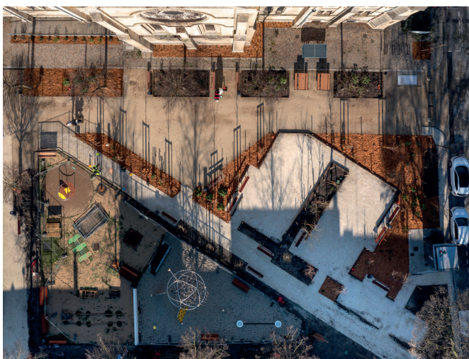
Vue aérienne après travaux, © Sibelait
