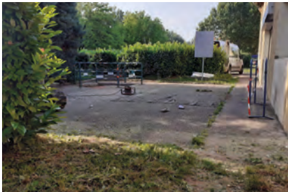
Préparation du chantier, © Grand Lyon
