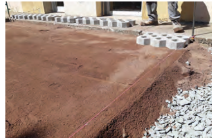
Pose d'une surcouche de sable, © Grand Lyon
