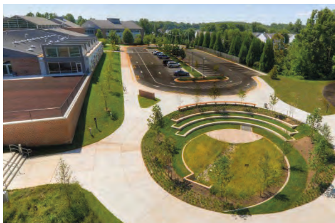
Multifonctionnalité d'un ouvrage de gestion des eaux pluviales, Manassas Park, Etats-Unis, © Sarah Lacombe
