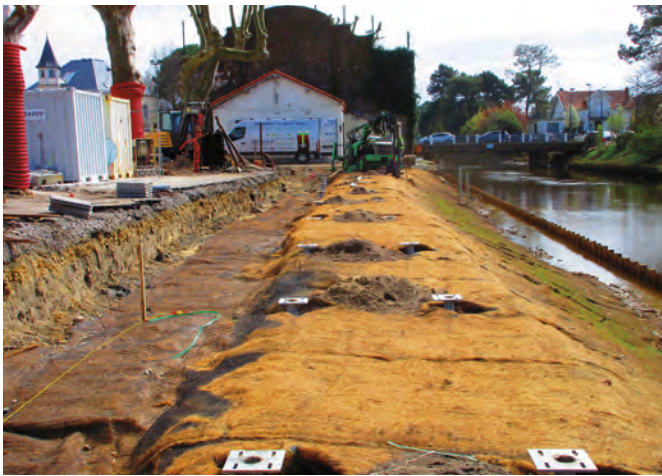
Installation des pieux pour l'accueil des platelages bois, © Technopieux
