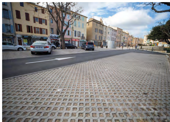
Pavés drainants et zone de pleine-terre pour un parking du centre-ville de Narbonne, © Ville de Narbonne
