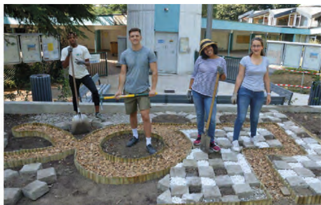
Chantier Concordia, © Le Dauphine
