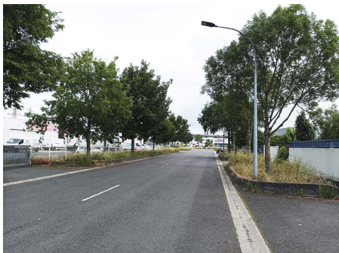
Rue Roger Touton , très arborées avec tranchées plantées
