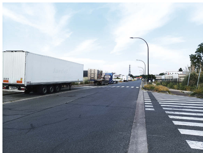
Des rues très larges, très imperméabilisées , Rue Edmond Besse
