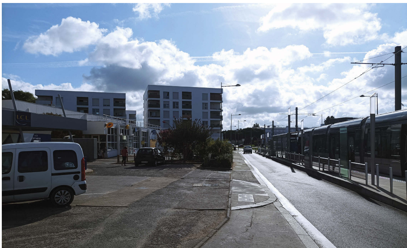
Rive nord de l'avenue Roger Schwob en mutation, construction de logements.
