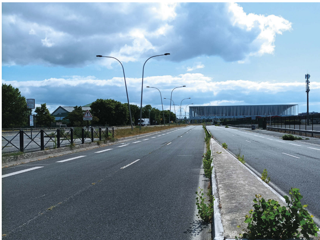
Le cours Jules Ladoumègue : un axe de circulation surdimensionné au regard du trafic
