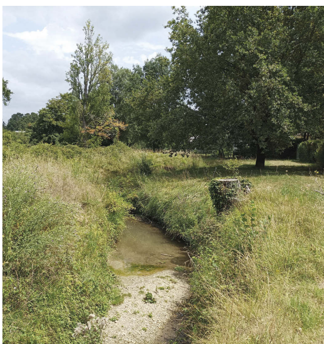
Des ripisylves discontinues et des berges érodées
