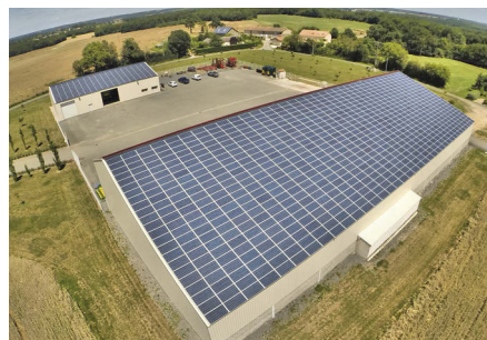
1 – Bâtiment de stockage agricole, Chauvigny (86) © Technique Solaire
