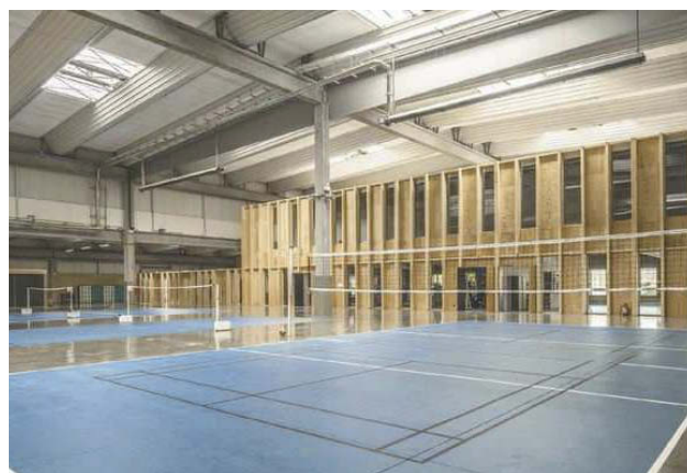
Hangar de stockage transformé en équipement sportif - Toulouse : approche modulaire et réversible (intégration de volumes à ossature bois à l'intérieur de l'enveloppe principale du hangar). By V2S Architectes. Source : Le Moniteur, 9 août 2019
