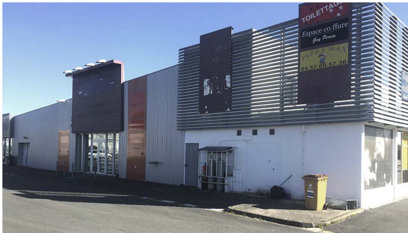
Retail parc de Saint-Seurin-sur-l'Isle.
