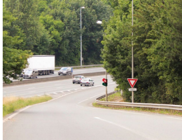
FRANCE – Bordeaux - Feux de régulation des accès
