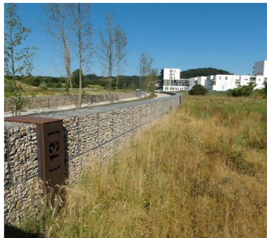
LUXEMBOURG – Belval – Retenue d'eau aménagée
