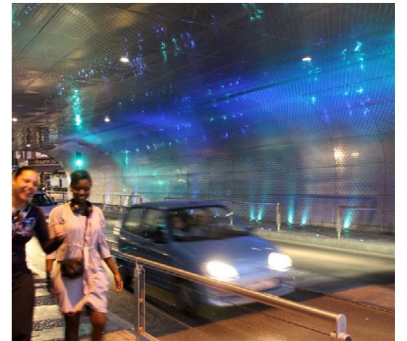
FRANCE – Mise en lumière d'un tunnel
