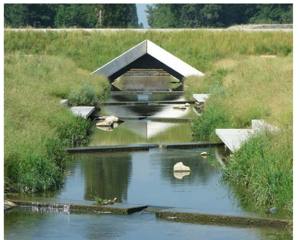
SUISSE – Renaturation de la rivière Aire
