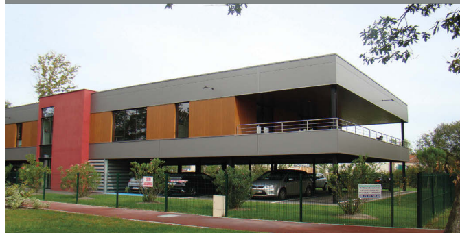
Locaux de bureaux - Mérignac (zone de Cadéra)
