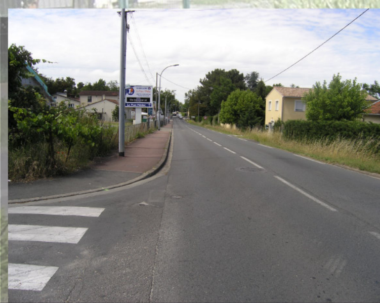
Av. du 11 novembre – Voie intercommunale
