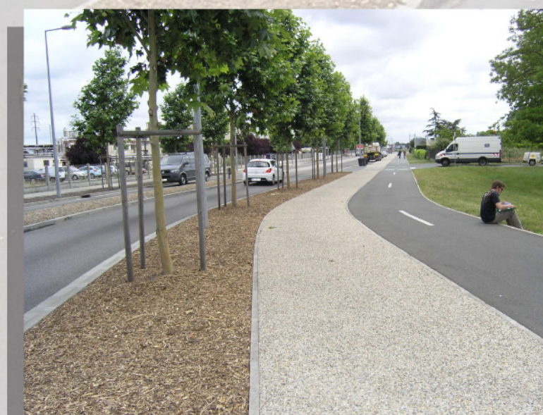
Rue Jean Duvert – Voie intercommunale Photo 04 - Présence d'une piste cyclable unilatérale à double sens - Réel partage de l'espace public par tous les modes de déplacement - Trafic routier élevé
