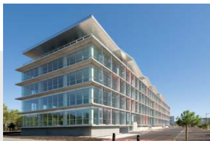
ARCHITECTE : A. TRIAUD
