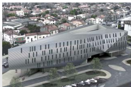
ARCHITECTE : A. TRIAUD
