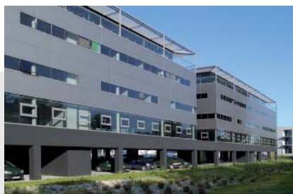
ARCHITECTE : A. TRIAUD
