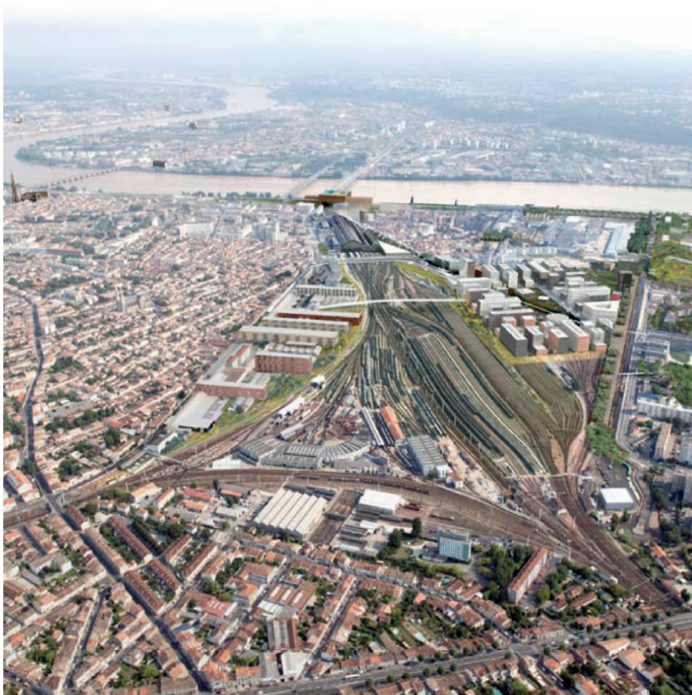
Vue aérienne de l'Opération d'intérêt national (OIN) Bordeaux Euratlantique
