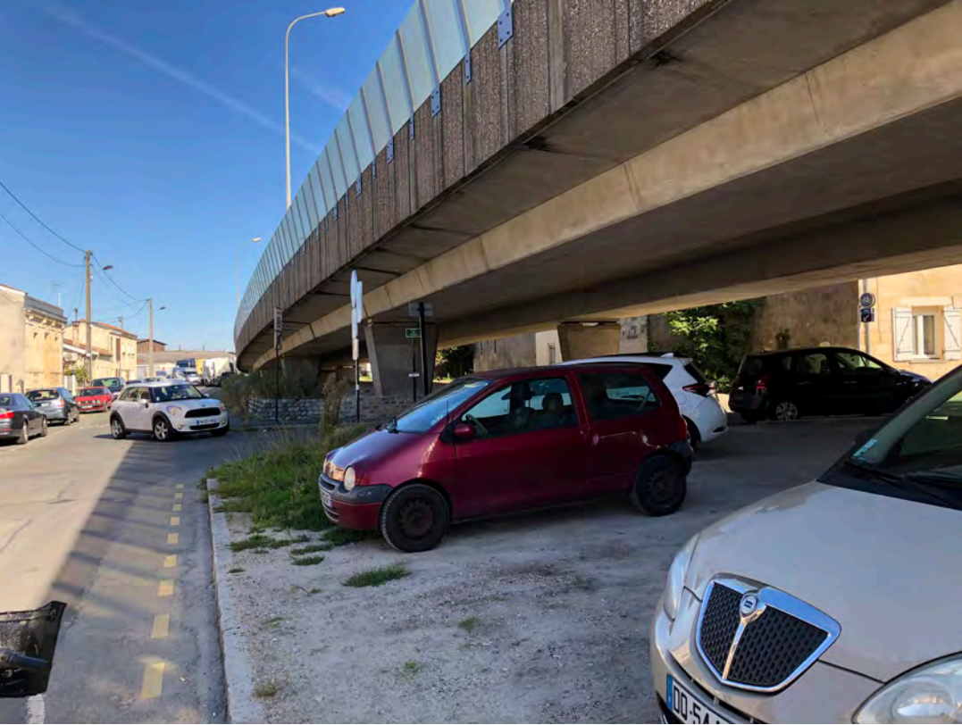
Stationnement sauvage sous le pont Saint-Émilion / boulevard André Ricard
