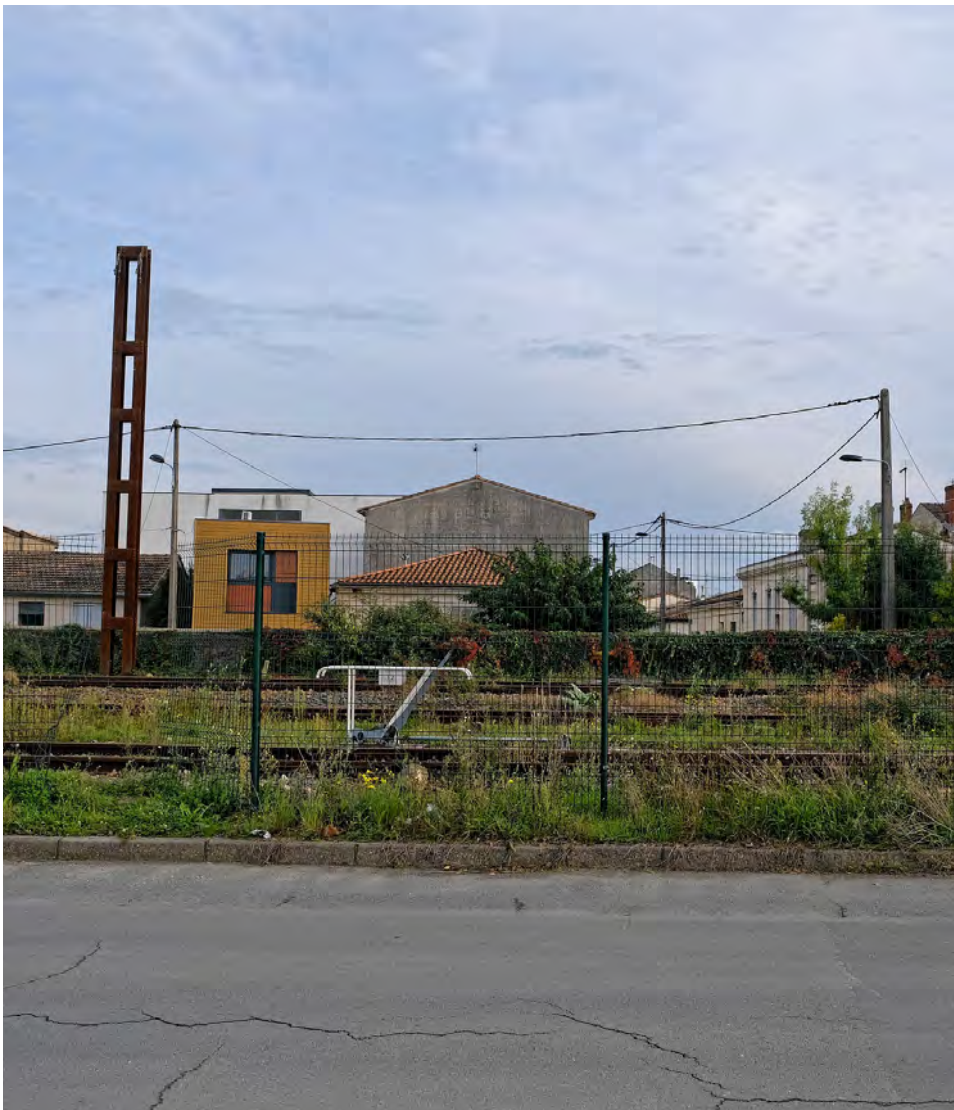
Des voies ferrées qui scindent le territoire
