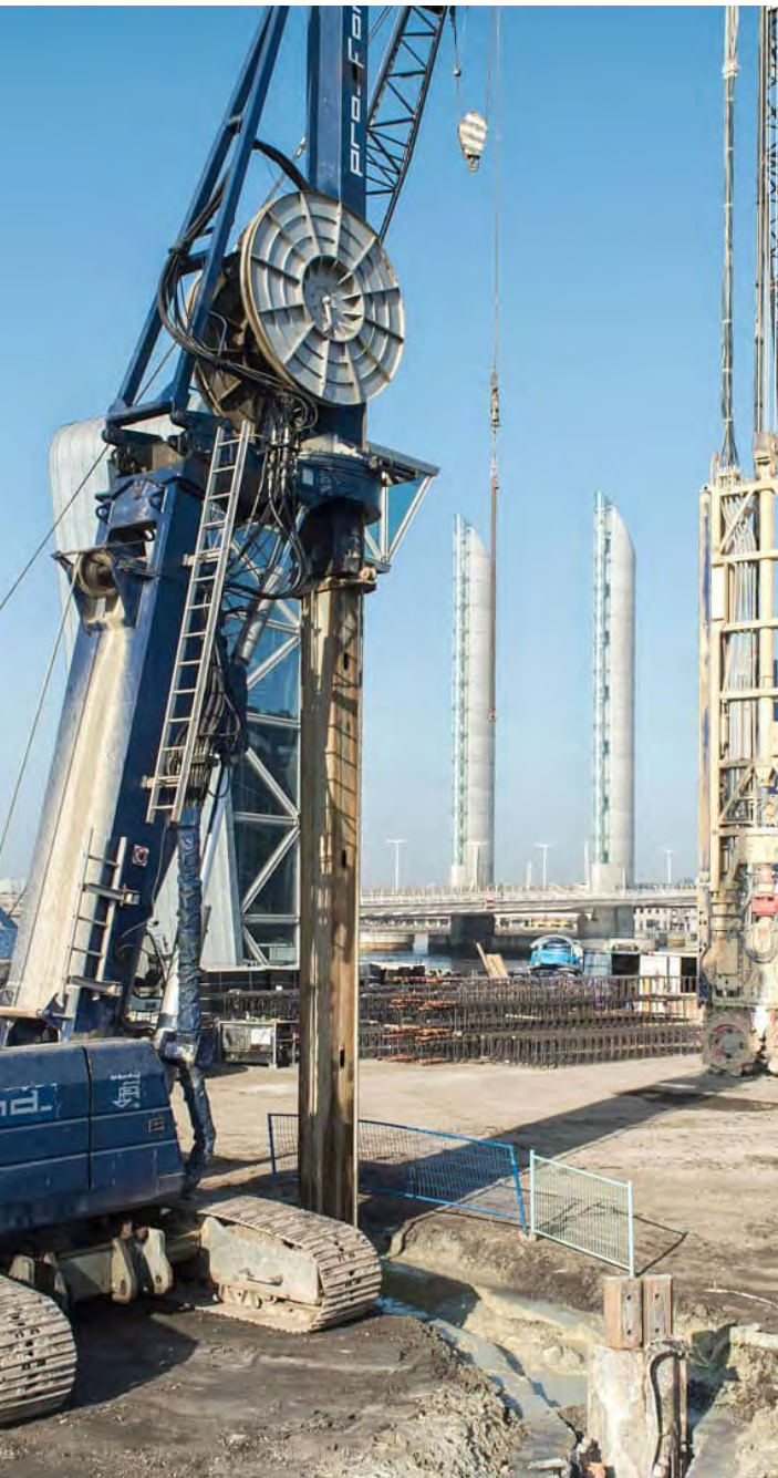
Chantier du tunnel Brazza crédit Bordeaux Métropole
