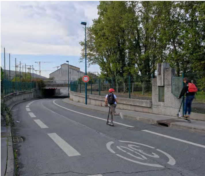
Passage inférieur sous la voie ferrée - rue Lajaunie
