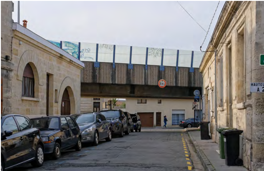
Une infrastructure déconnectée du sol, rue René Michel, Cenon
