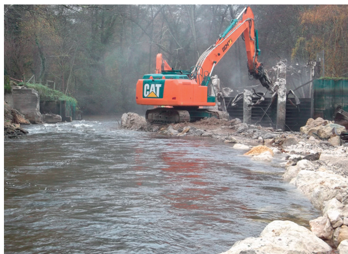
Installation d'un lit rocheux pour limiter l'impact de l'arasement du barrage, © Sylvain Brogniez
