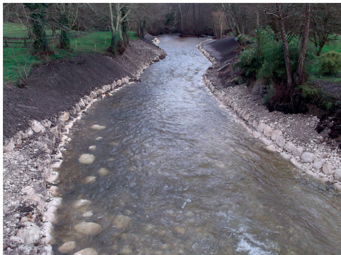
Enrochement des deux côtés des ripisylves du cours d'eau, © Sylvain Brogniez
