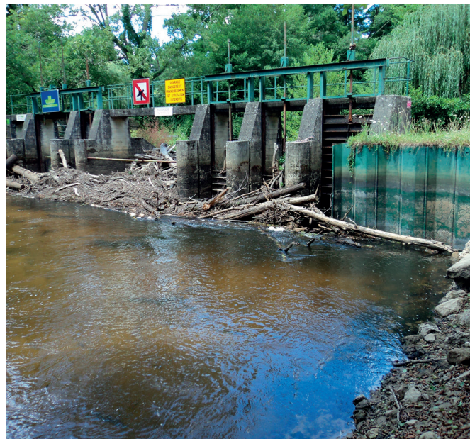
État du barrage avant les travaux d'arasement © Sylvain Brogniez
