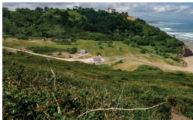
Travaux de renaturation de l'Espace Naturel Sensible (ENS) d'Erretagia, Bidart, © ARB Nouvelle Aquitaine
