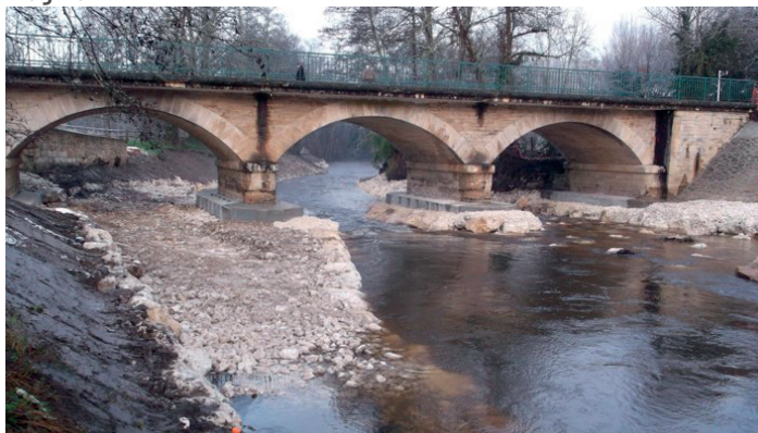
Renforcement des piles de la RD 3, © Sylvain Brogniez
