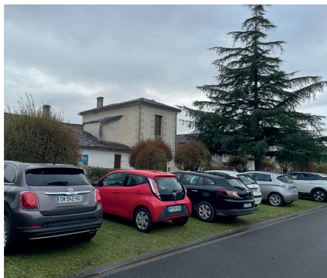
Aire de stationnement drainante créée (secteur B) © a'urba
