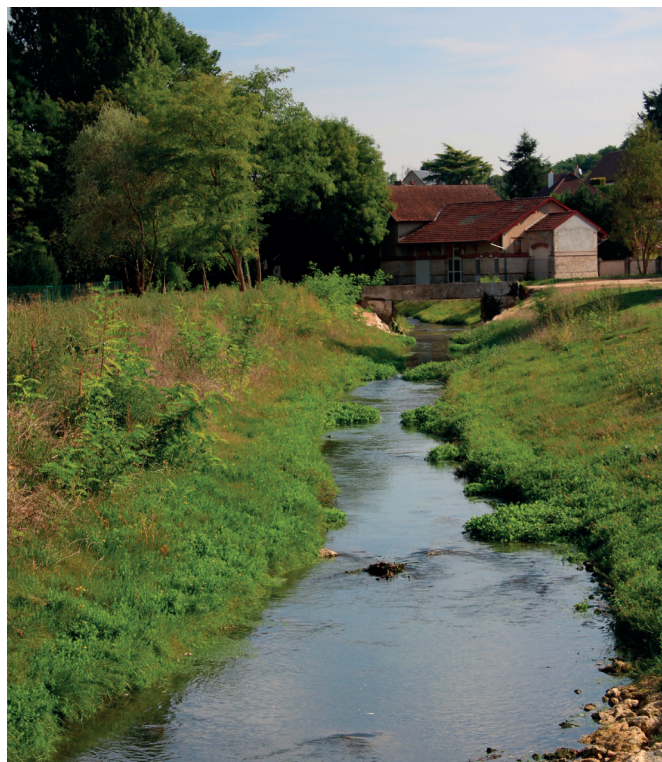
Renaturation des berges d'un cours d'eau © Syndicat intercommunal pour l'entretien et l'aménagement de la Brenne et ses affluents
