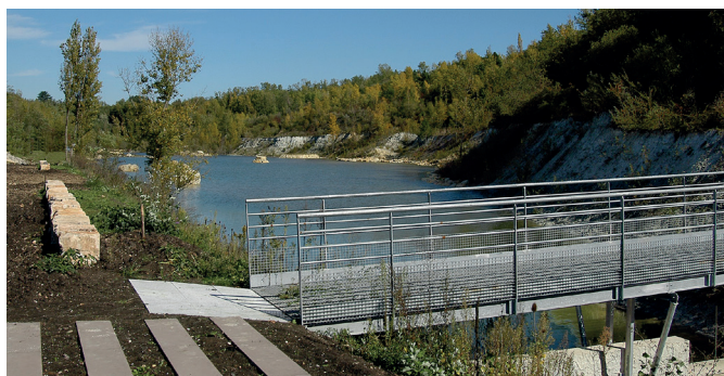
Passerelle métallique pour rappel du passé industriel du site © Lormont
