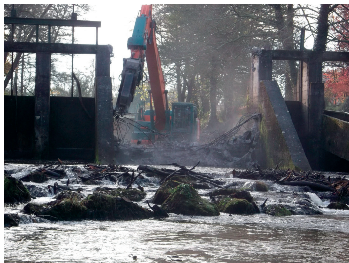
Déconstruction du barrage, © Sylvain Brogniez
