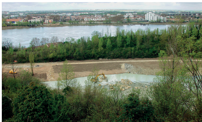
Phase travaux, création du lac de l'Ermitage, 2004 © Lormont
