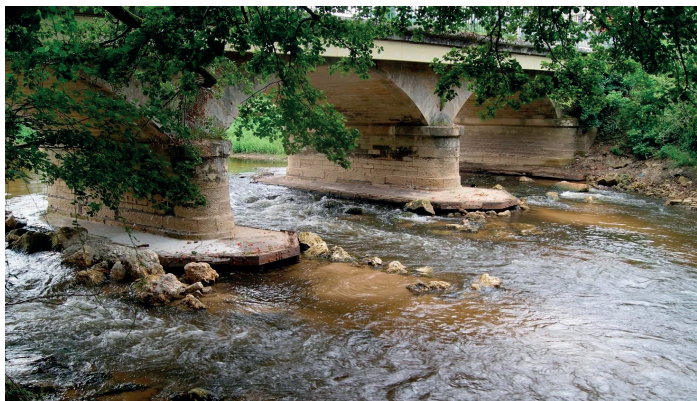
Piles du pont de la RD 3 avant les travaux de renforcement, © Sylvain Brogniez
