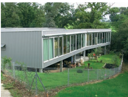
L'intégration du bâti dans la pente
