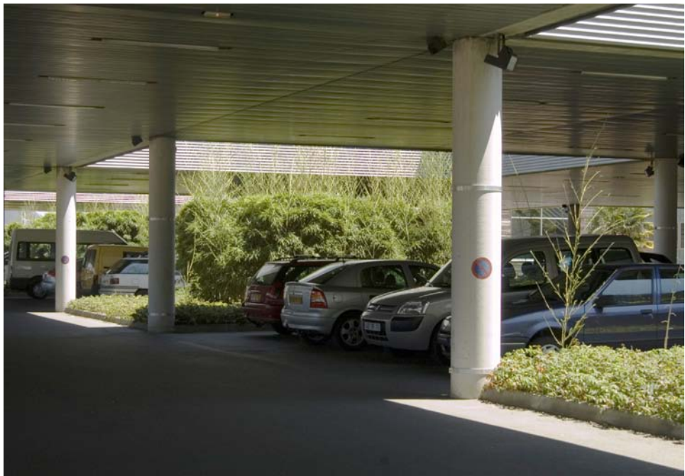
Parking sous bâti, Institut de Chimie de la Matière Condensée, CNRS (ICMCB), avenue Pey Berland, avenue du Dr A. Schweitzer, Talence O. Brochet - E. Lajus - C. Pueyo, architectes (1995)
