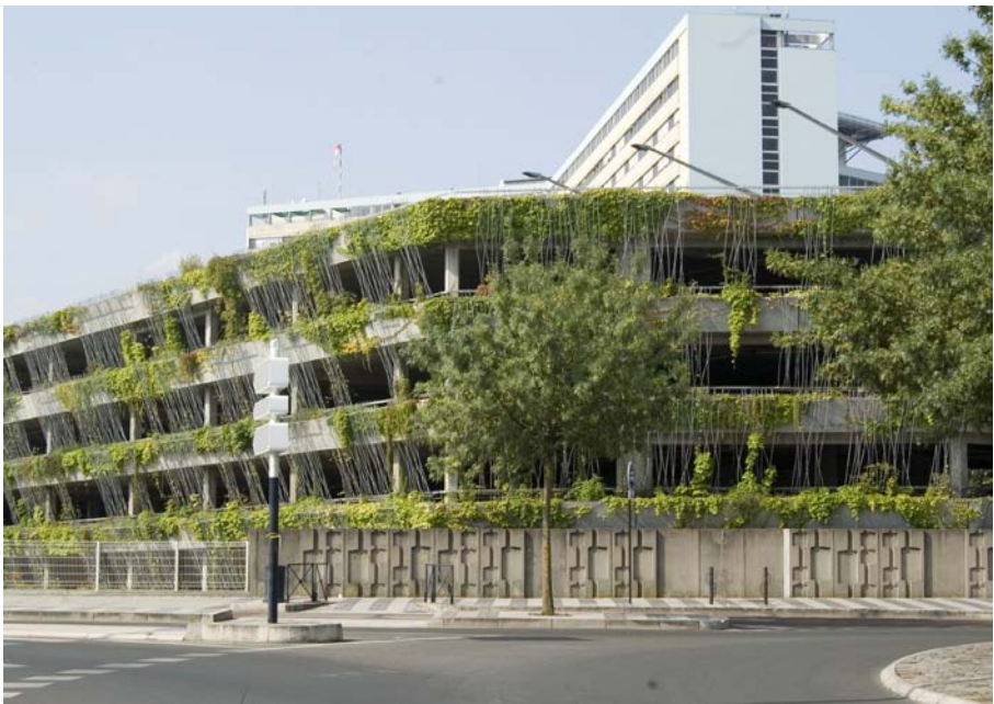
Parking en silo, CHR Pellegrin, rue de Canolle, Bordeaux L. Arsène Henry, A. Triaud, architectes
