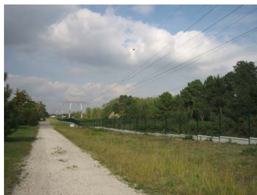
Ligne à haute tension
