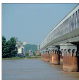
La passerelle ferroviaire
