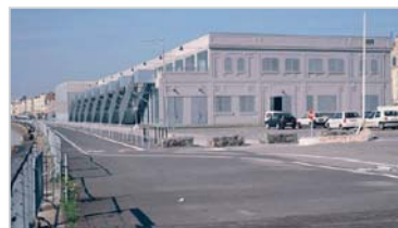
Le hangar H14
