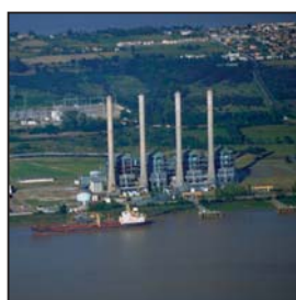
Centrale électrique du Bec d'Ambès
