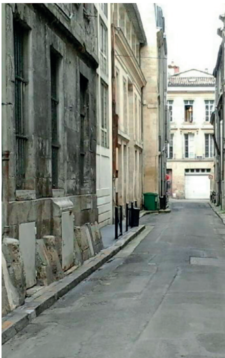
Un trottoir inexistant Rue Tustal - Bordeaux © a'urba
