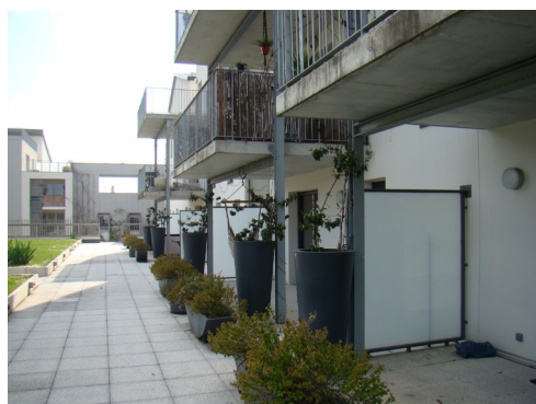
Toit du parking végétalisé formant une terrasse partagée
