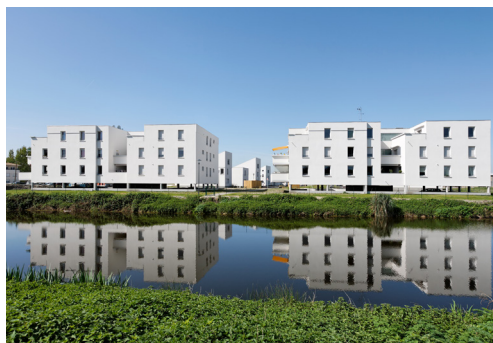
Espace de détente le long du canal - © : Vincent Monthiers
