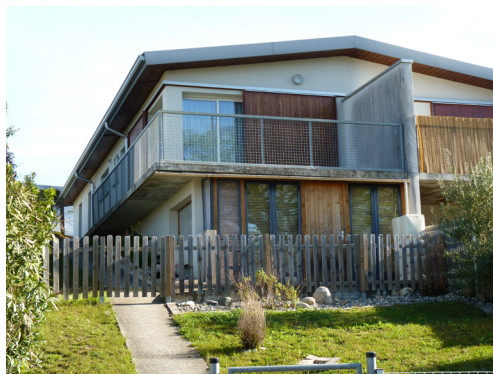
Ajout d'une pièce sous la terrasse
