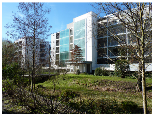
Aménagement paysager et grandes noues
