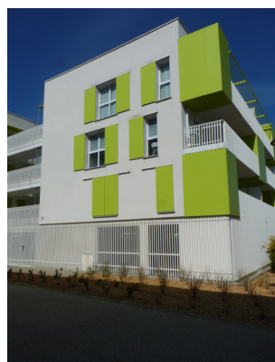
Ouvertures équipées de volets coulissants sur le pignon sud-est
