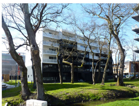
Façade Est donnant sur un espace boisé
