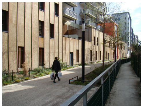
Socle du bâtiment
