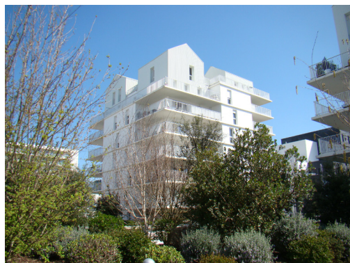
Maisons sur les toits
