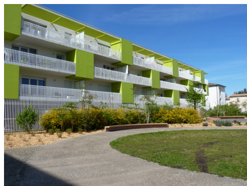
Celliers dans les loggias ; végétation en pied d'immeuble
