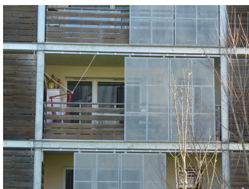
Protection solaire des balcons en façade ouest
