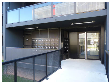
Porche d'entrée abritant les boîtes aux lettres
