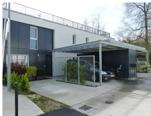
Place de stationnement et cellier devant chaque maison
