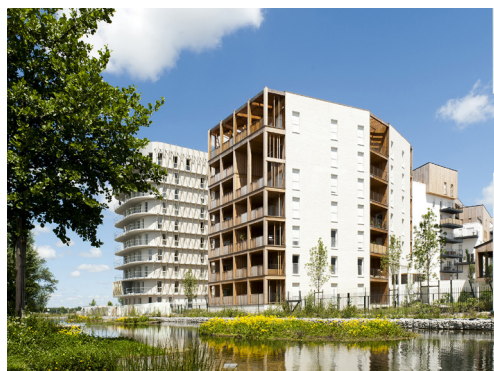
Accès aux différents blocs - © La Nouvelle Agence
