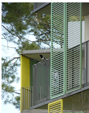
Persiennes coulissantes pour le confort thermique et l'intimité
