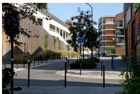
Parking sous 3 niveaux sous les logements
