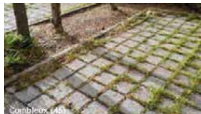
Exemple d'un revêtement de sol perméable.
