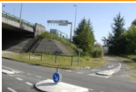
Raccordement au réseau cyclable urbain.
