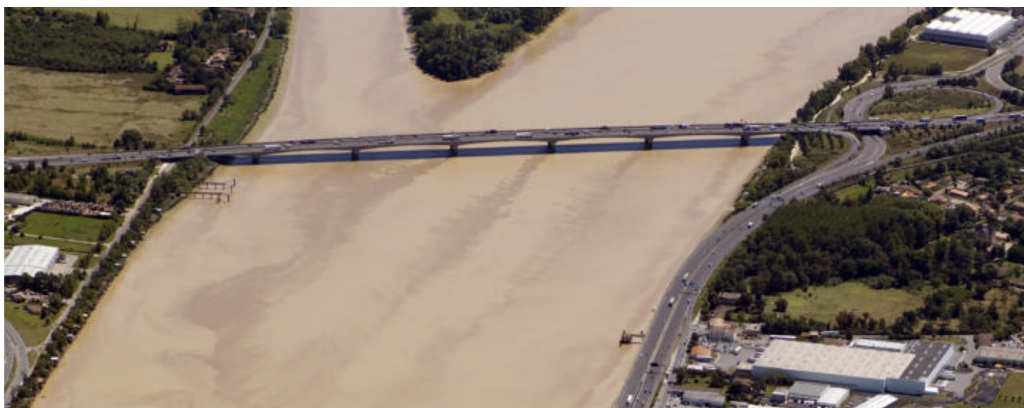
Vue aérienne de l'ouvrage, raccordement aux voies sur berges.
