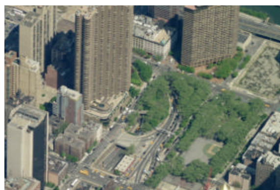
Sortie ouest du tunnel
