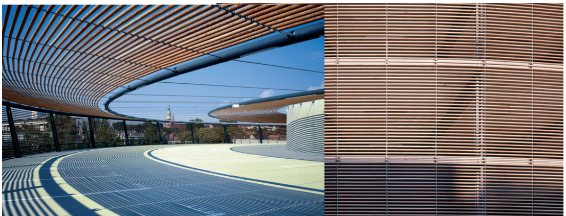
Parking Silo de 450 places - Offenburg / Allemagne - Werner Sobek architecte 2002
