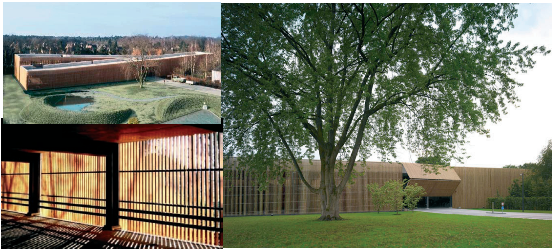
Parking Silo de 500 places - Coesfeld-Lette / Allemagne - Birk und Heilmeyer architectes 2007
