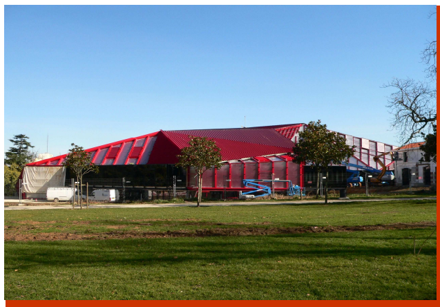
Construction du pôle culturel à Palmer
