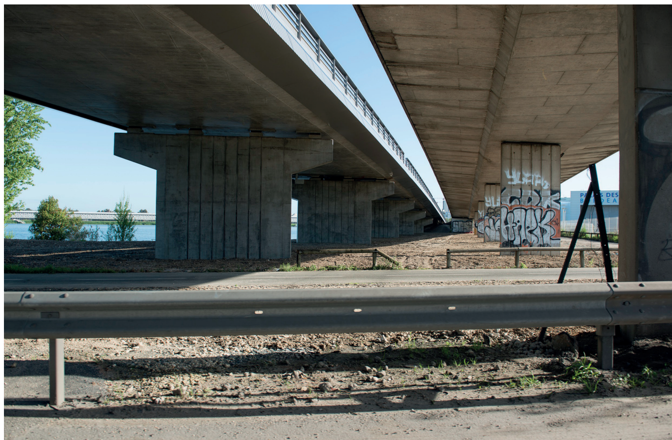
Sous-face infrastructurelle - Rociade - Bordeaux Nord
