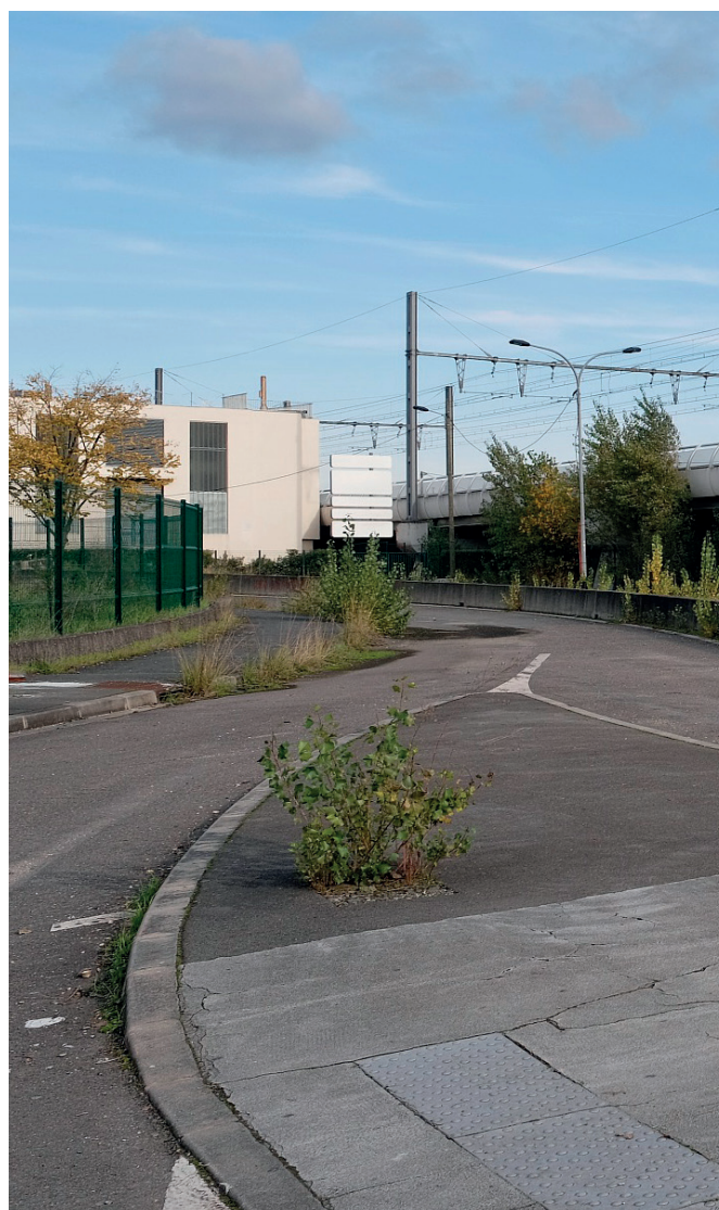
Vue de la bretelle d'accès au pont Saint-Jean désaffectée - Bordeaux
