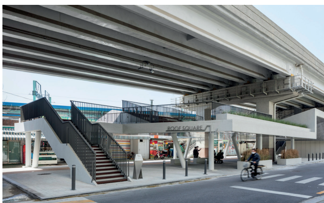
Roof square - HG architecture - Séoul - Corée du Sud © Kyungsub Shin
