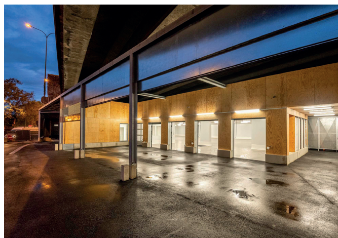
P4 - Entrepôt logistique - sous le périphérique parisien - SOGARIS - Mairie de Paris - Concepteur : Syvil - 2020 © Sogaris
