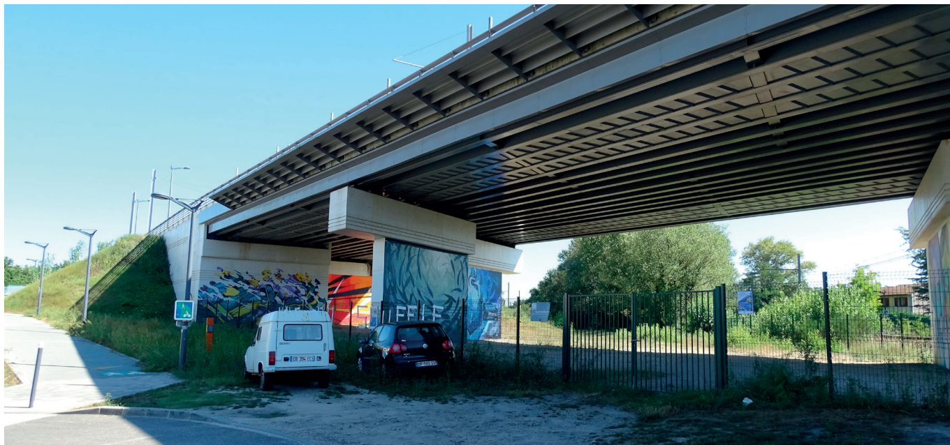
Délaié inaccessible sous la station Ausone en lien avec une friche - tram D - en limite du parc Ausone - Bruges
