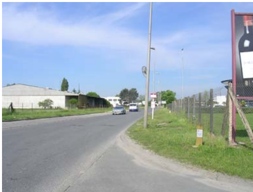
Des accotements non aménagés - rue Guynemer
