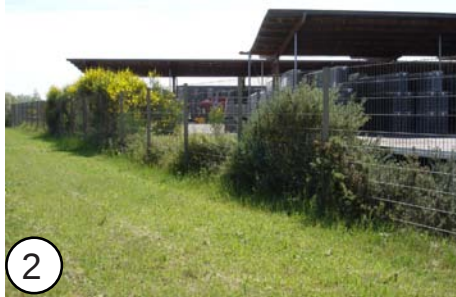
Utilisation de la végétation locale pour créer une haie : genêt et ajoncs
