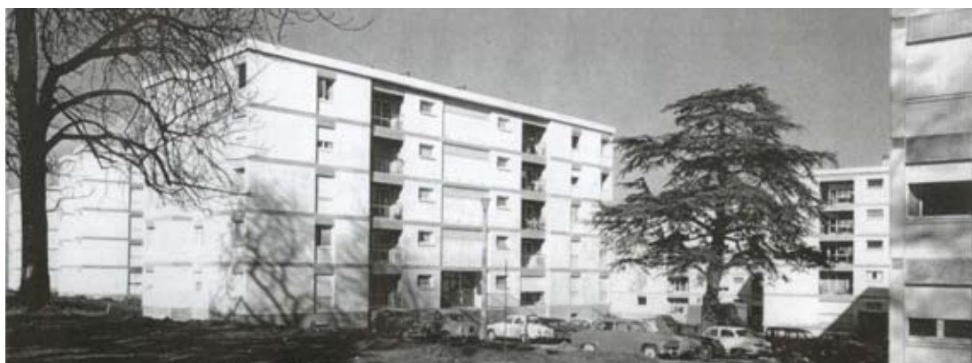
Bâtiment « bloc » Photographie - Collection Pierre Mathieu
