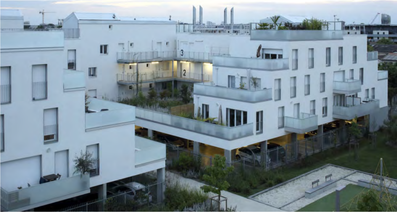
Vue d'un îlot © Bordeaux Métropole / Rollet
