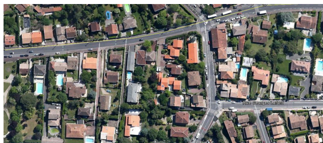
Bâti en recul G. Lafont
