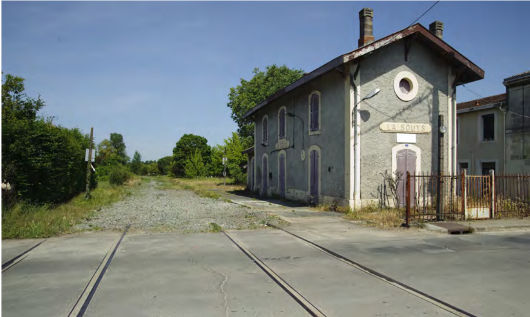
Patrimoine bâti : ancienne halte ferroviaire de la Souys © a'urba
