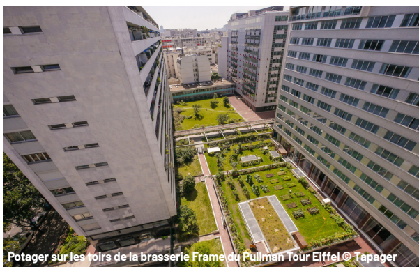
Potager sur les toits de la brasserie Frame du Pullman Tour Eiffel © Tapager
