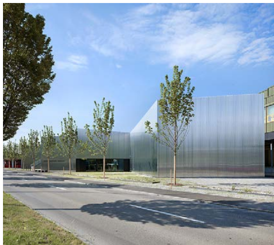
SUISSE – caserne pompier à Weinfelden
