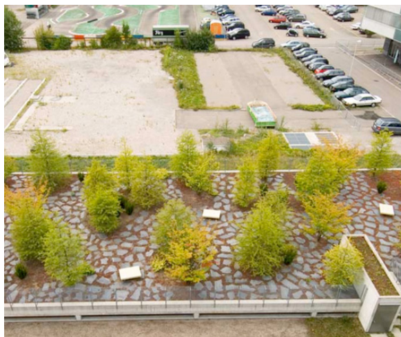
SUISSE – Wallisellen – Débitumage et phyto-remédiation
