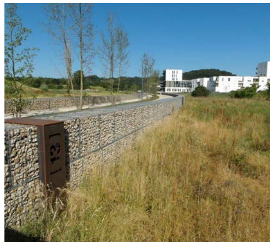
LUXEMBOURG – Belval– Retenue d'eau aménagée
