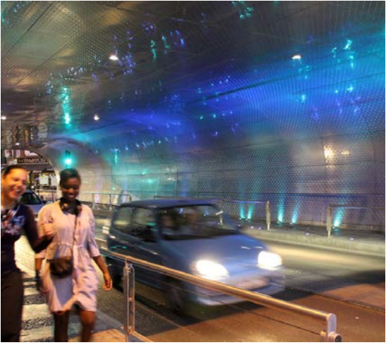
FRANCE – Mise en lumière d'un tunnel
