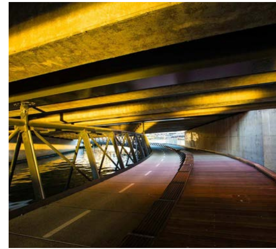
AUSTRALIE – Sous-face du pont Jim Stynes
