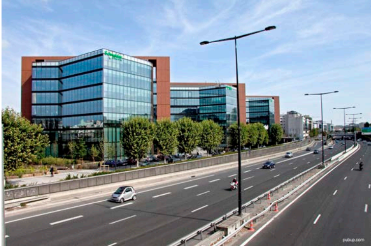
FRANCE - Rueil Malmaison A86
