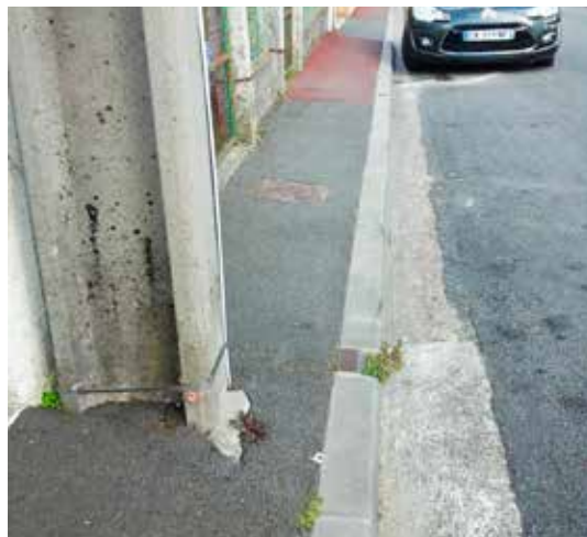
La conjonction de difficultés : un obstacle sur un trottoir étroit et incliné.
