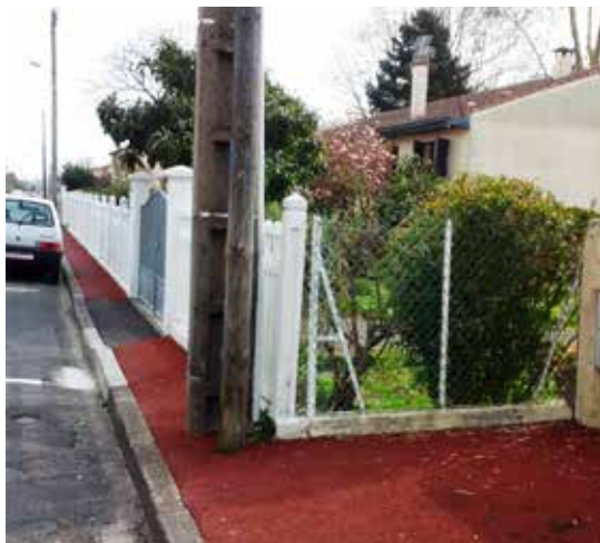
Des rétrécissements du trottoir avec obstacle.
