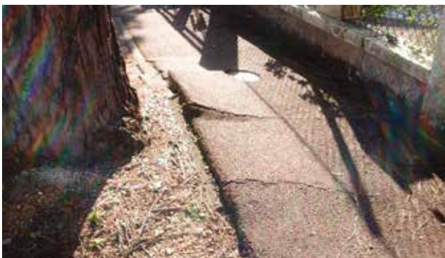
Des déformations du trottoir par des racines (pins de la place Sainte-Bernadette).
