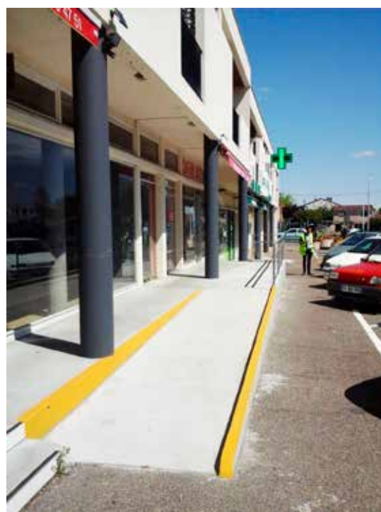
Des aménagements adaptés : rampe, bande d'éveil, nivellement.
