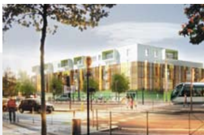
ARCHITECTE : LANOIRE ET COURNIAN
