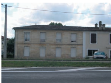
Bâti traditionnel au Trujeau
