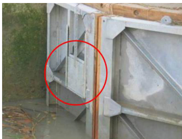
Exemple de dispositif de franchissement de portes à flot : installation de vantes (source : ONEMA)
