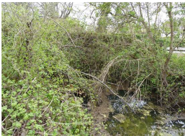
Exemple de tronçon de cours d'eau non entretenu sur le bassin versant du Guâ
