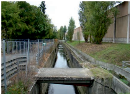
La traversée du Guâ à Carbon-Blanc (Source : a'urba)
