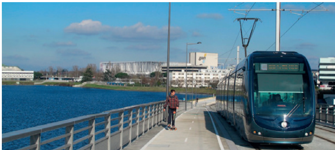
Le tramway franchit la rocade sur l'échangeur 4b, vers Bordeaux-Nord
