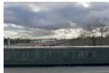
Lignes ferroviaires d'Hourcade - Villenave-d'Ornon
