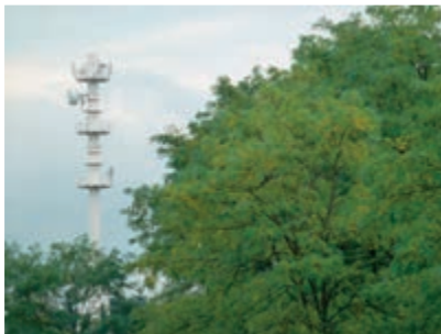
Pylône de téléphonie - Bruges
