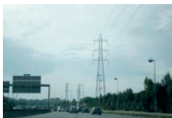
Lignes à haute tension - Bouliac
