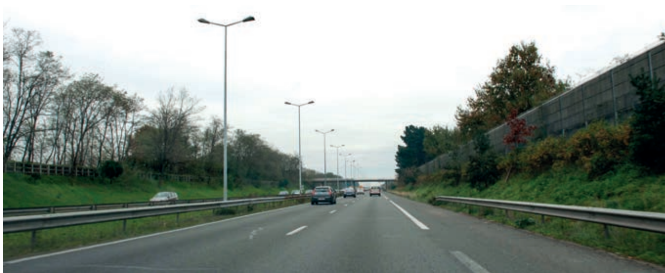
Végétation plantée pour la rocade : « végétation filtre » le long des talus et murs antibruit
