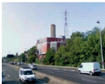
Le complexe thermique des Hauts de Garonne - Floirac
