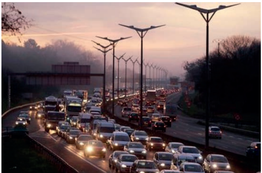
Eclairage sur la rocade
