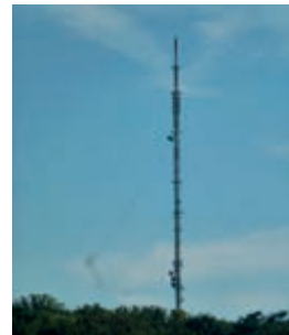
Tour de télécommunication - Bouliac
