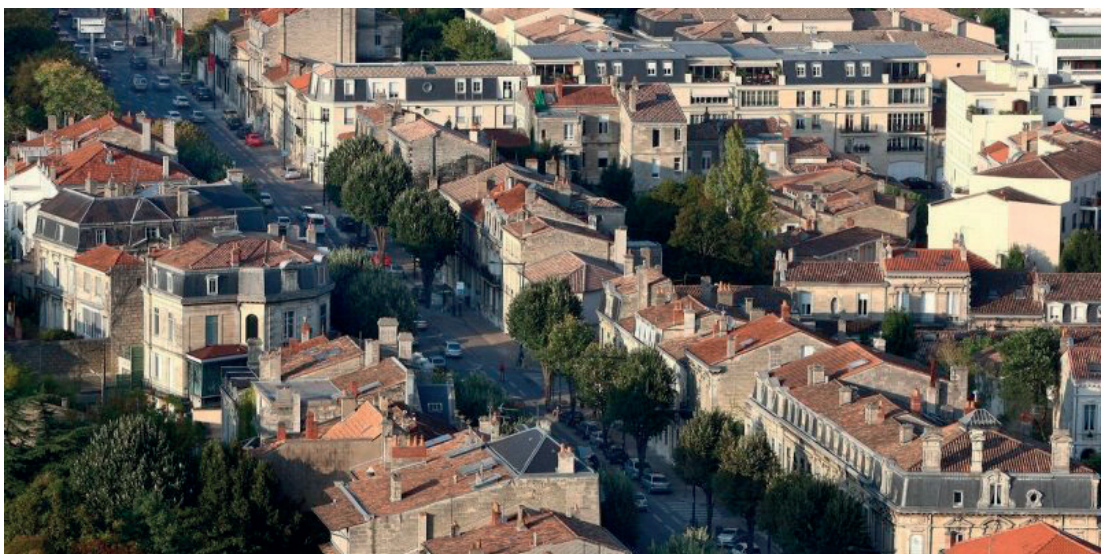
Une partie de la ceinture des boulevards bordelais : anneau de 12 km sur lequel passent 20 000 voitures en moyenne par sens et par jour (= 40 000 voitures/jour)
